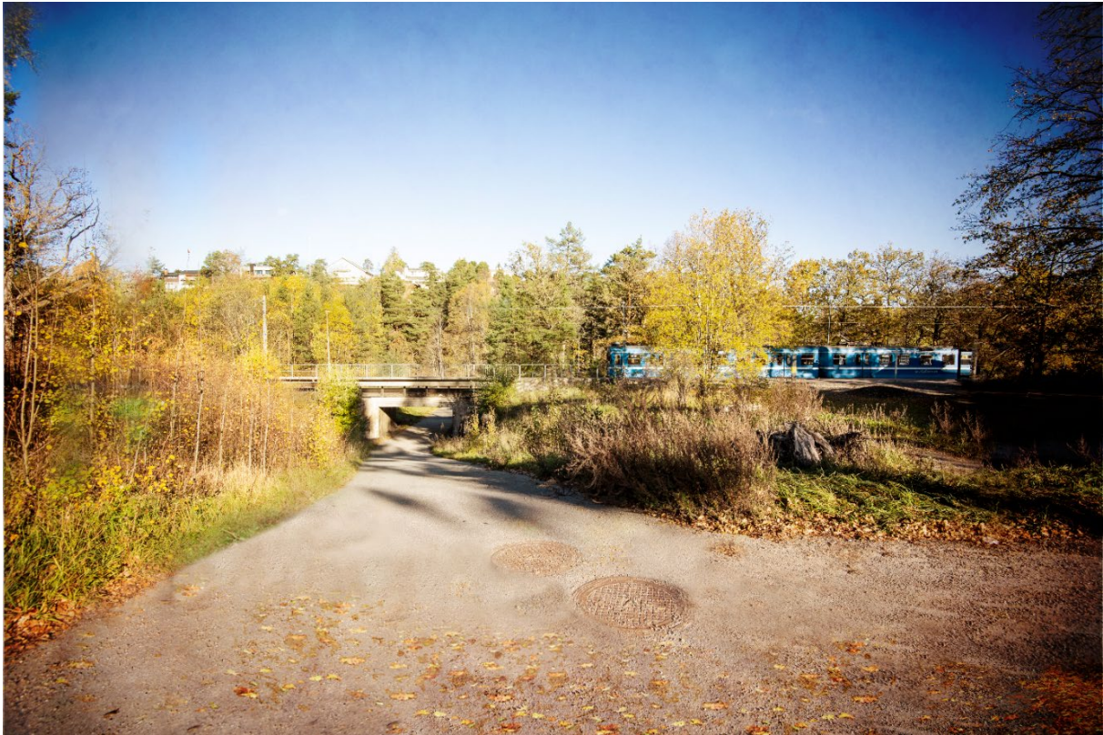
Dagens gång- och cykelväg och gång- och cykeltunnel, vy från söder. Foto av Sweco.
