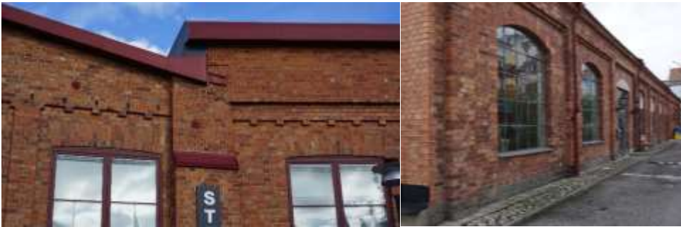
Industribebyggelse från förra sekelskiftet i Järila sjö, exempel på detaljer med djupverkan samt material och kulör. Till vänster gjuteriet och till höger pumpprovningen. Foto: Johannes Kruusi
