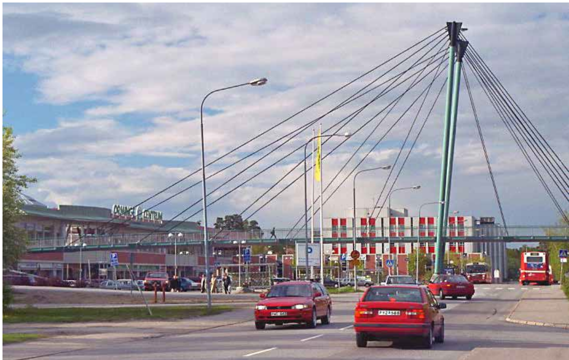
Orminge centrum, Kanholmsvägen. Centrumbuset till vänster i bilden och Ormingebus bakom snedkabelbron.
