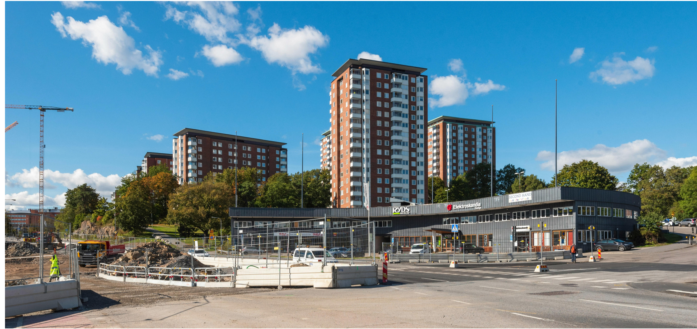
01. FÖRE BEFINTLIG SITUATION.
