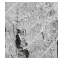
SOCKEL SAMT FASAD LÄNKBYGGNAD GROVHUGGEN SVENSK GRANITSTEN
