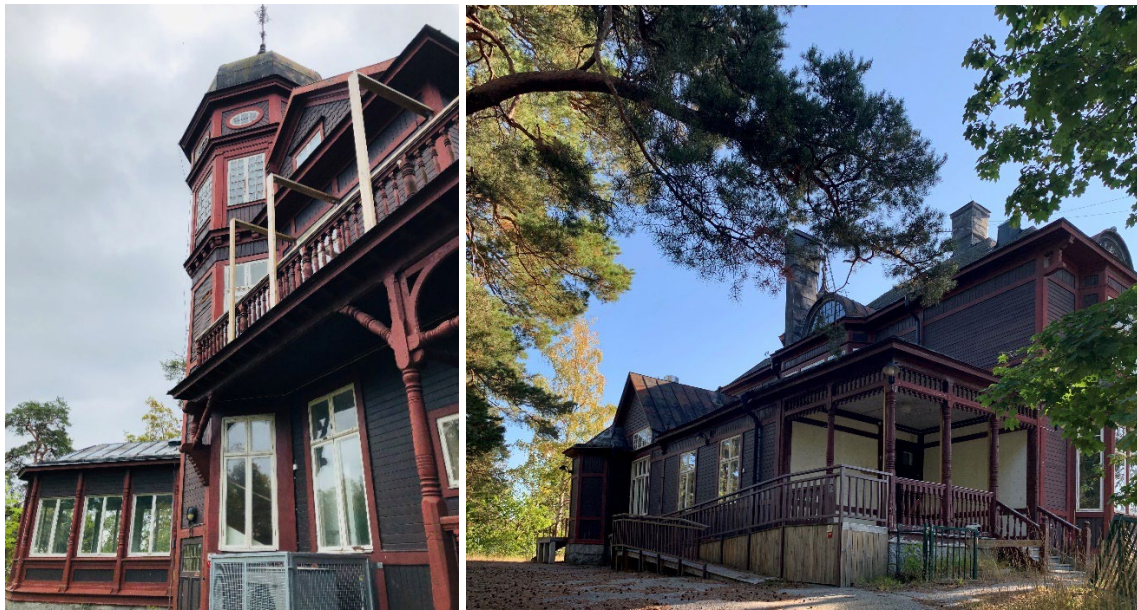
Figur 3 & 4. Villa Gadelius norra fasad (t.v.) samt västra fasad (t.h). Foto: Nacka kommun, 2020
