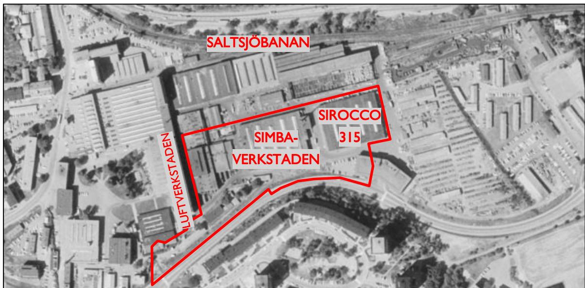
Figur 18. Flygbild från 1975 där de två industrihallarna ses mitt i bilden. Bild: Kulturmiljöanalys (White arkitekter, 2021)
