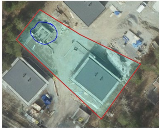
Flygfoto från 7 maj 2023 som visar att byggnation är påbörjad, grunden för komplementbostadshuset är inringad i blått.
