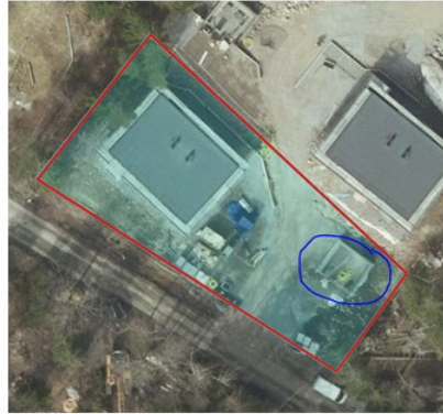
Flygfoto från 7 maj 2023 som visar att byggnation är påbörjad. Grunden för komplementbostadshuset är inringad i blått.
