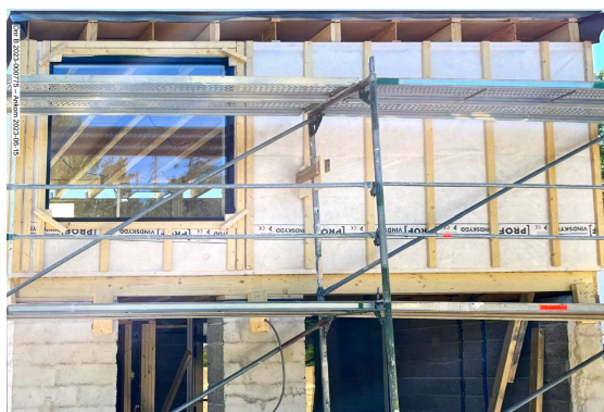
Foto från sökanden att byggnaden är under uppförande, inkom den 15 juni 2023
