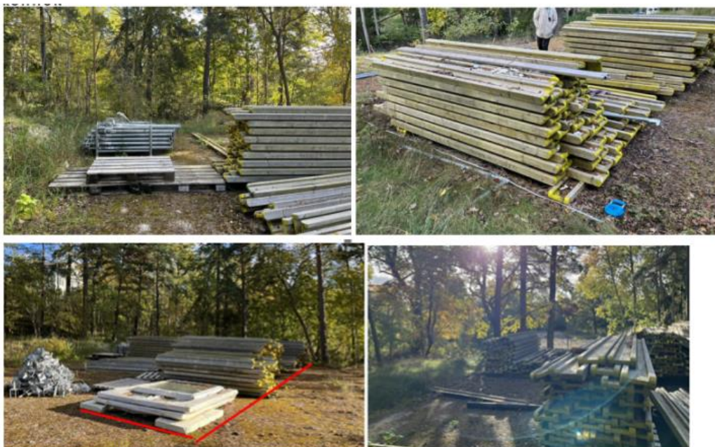
Delar av byggställning samt övrigt byggmaterial uppmättes till 10,2x3,5 meter, se röd markering.
