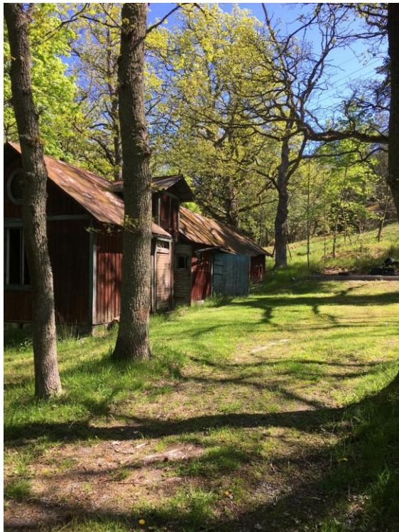
Bild 4: Förrådsbyggnaden som ska rivas
