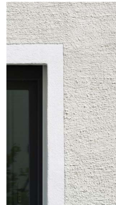
Ram av slätare, något ljusare puts runt trapphusfönster vid putsfasad
