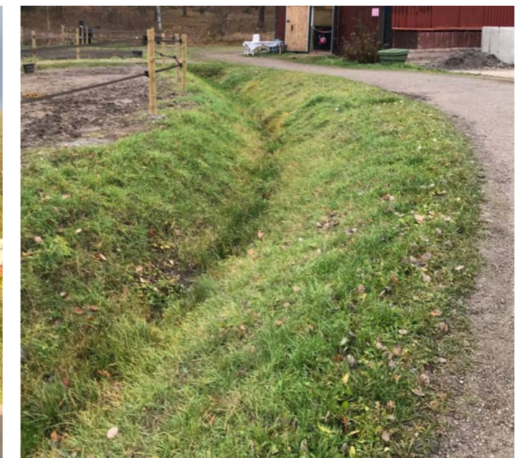
Referens täckdike för avledning av vatten och möte med grusad körväg, Säby gård.
