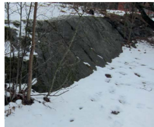
Referens önskad bergskärning med lutning nära Natura 2000.
