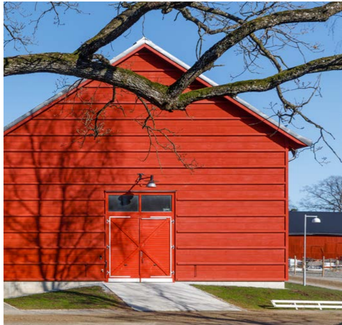
Referens betongramp vid Säby gård, Tengbom, Järfälla.
