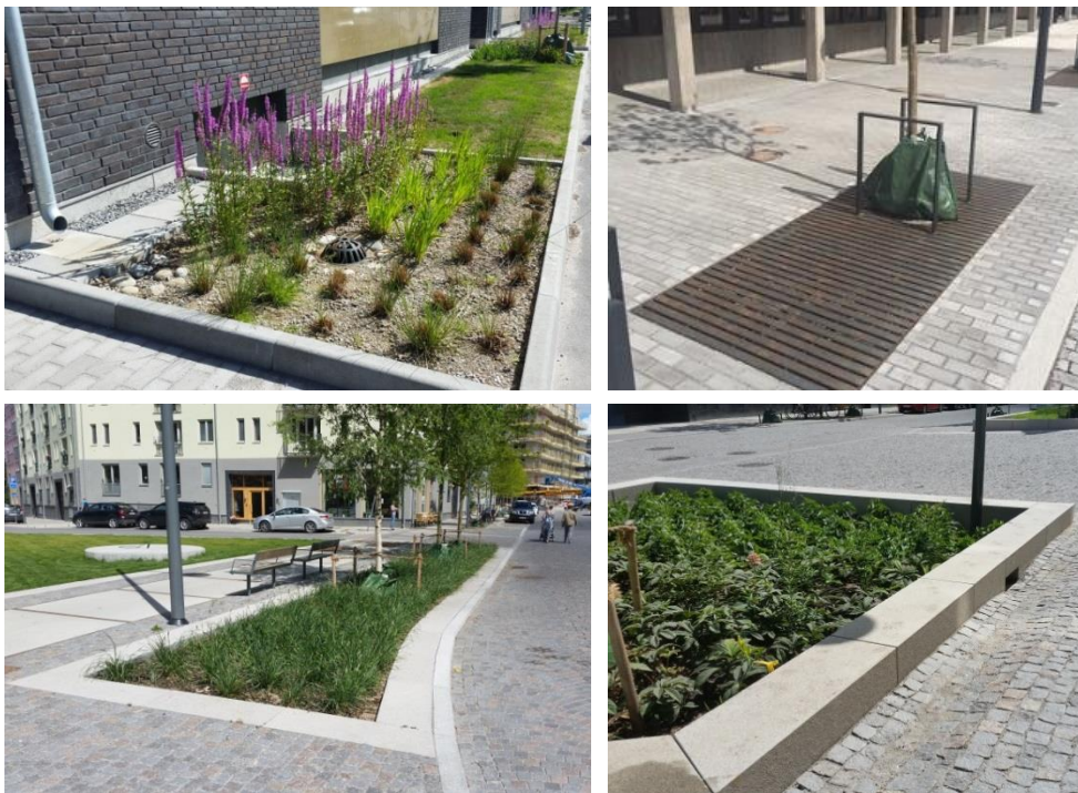
Figur 19 Växtbäddar. Ö.t.v. inledning via stuprörsutkastare, ö.t.h. växtbädd med markgaller, n.t.h inloppet via öppning i kantsten och n.t.v. inlopp på bred front via nollad kantsten.
