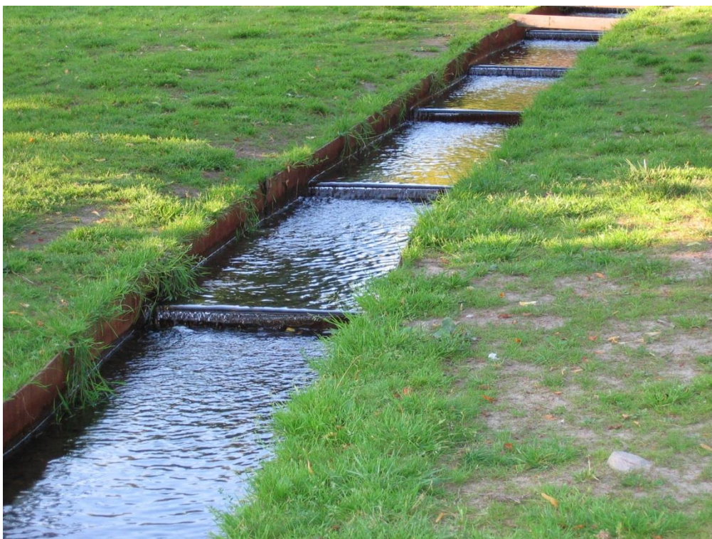
Figur 17 Exempel på dagvattenränna med överfall.
