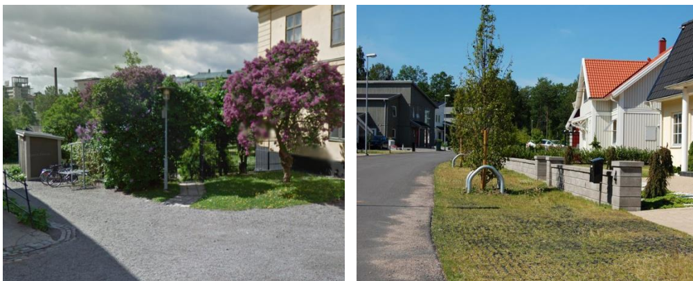
Figur 24 Grusad yta t.v. och gräsyta med pelleplattor (Vegtech) som förstärkning för att kunna köra på.
