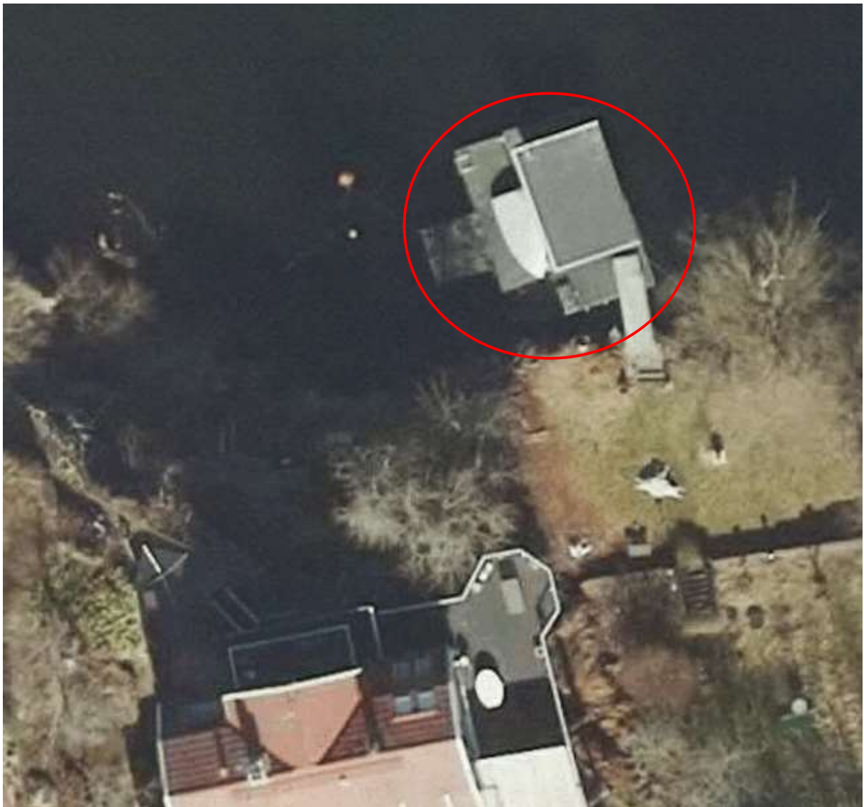
Anläggningar och bod som ska tas bort på Erstavik 7:7.
