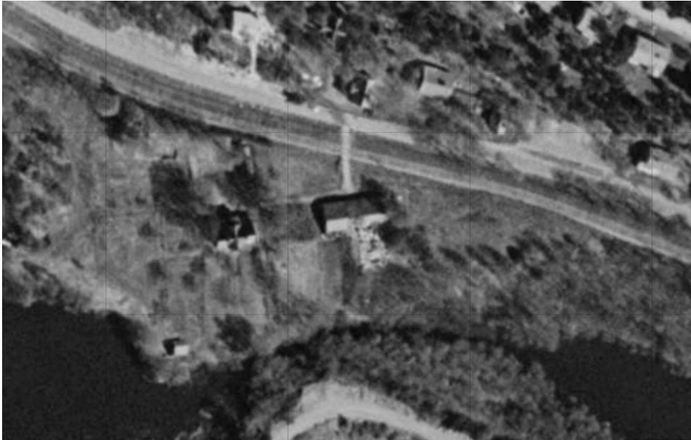
Flygfoto, sannolikt före 1955. En större ladugård fanns öster om huvudbyggnaden och gårdens infart leddes ursprungligen från norr.
