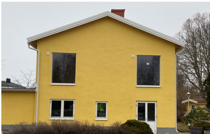
Fasad mot sydost. Foto från platsbesök 1 mars 2024 som visar de redan utförda fönstren på övre plan.
