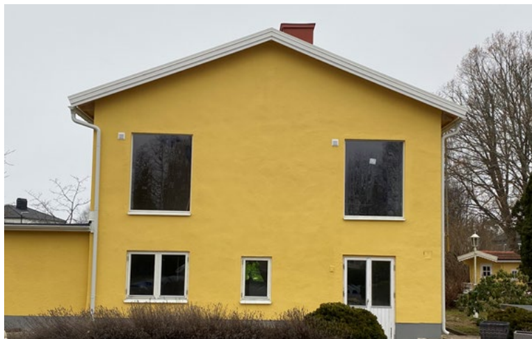
Fasad mot sydost. Foto från platsbesök 1 mars 2024 som visar de redan utförda fönstren på övre plan.
