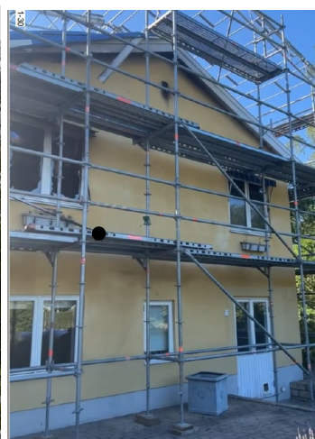
Foto inskickat av sökande 30 januari 2024 som visar fasad mot sydost innan åtgärden.
