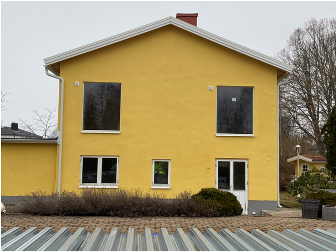
Fasad mot sydost. Foton från platsbesök 1 mars 2024.
