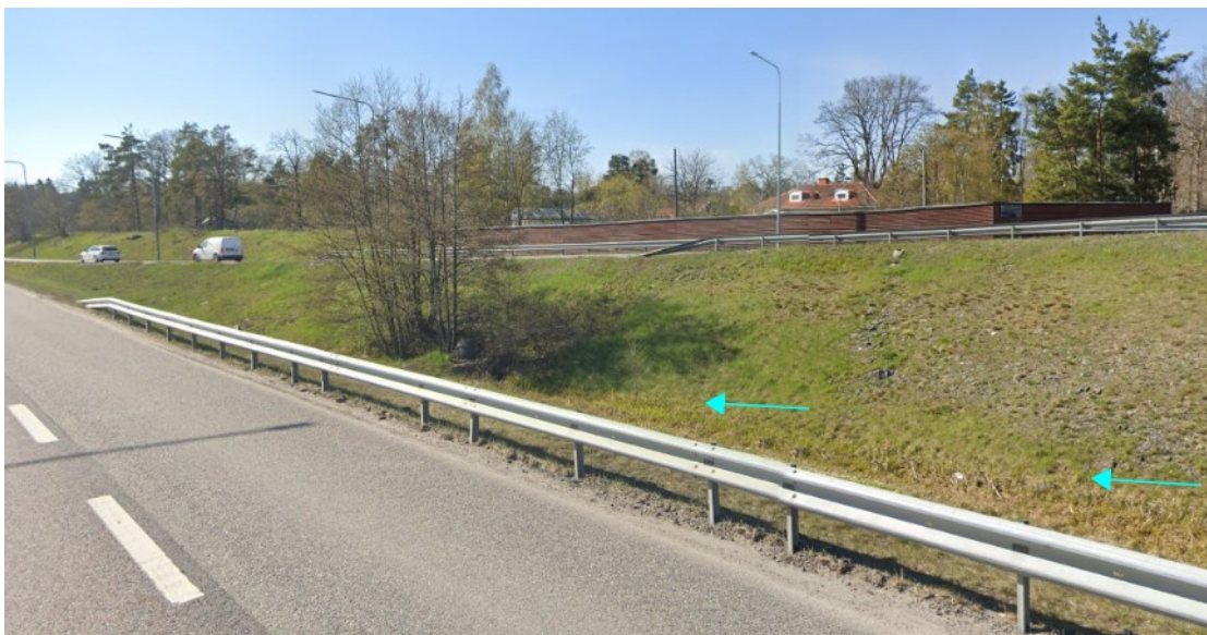
Figur 9: Befintlig nedstigningsbrunn i lågpunkt (Google maps 2023-08-25).
