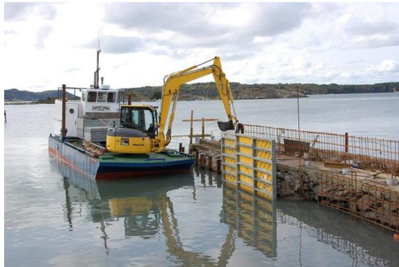
Figur 11, Mindre enskopeverk utför pirarbete.
