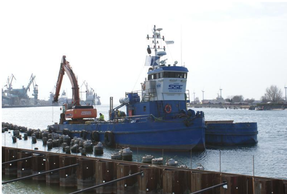
Figur 12, Arbetspråm för tyngre anläggningsarbeten från vatten.
