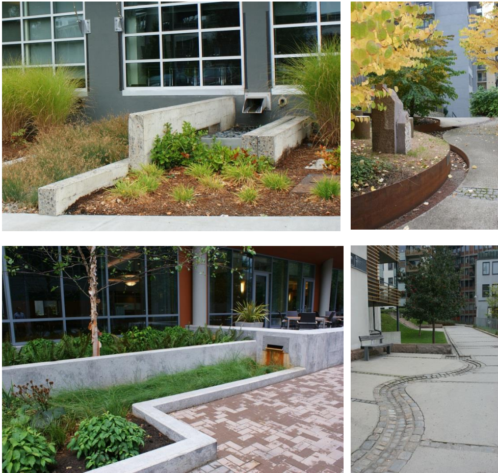
Figur 5. Exempel på utkastare och rännor kopplade till växtbädd.
