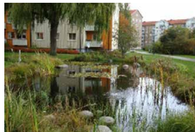
Exempel på dagvattendammar med naturlig utformning i bostadsnära bebyggelse, bild från dagvattenutredningen
