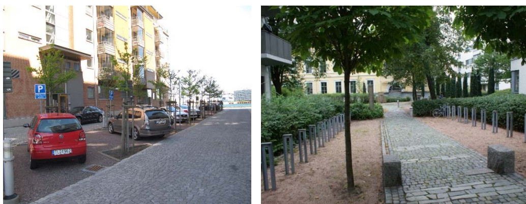
Figur 7 Exempel på permeabla beläggningar.
