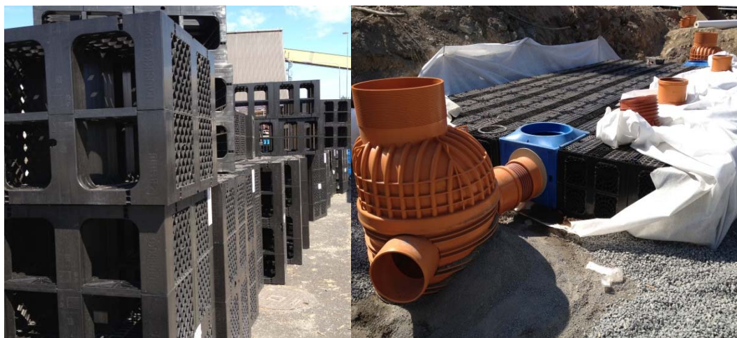
Figur 16 Exempel på dagvattenkassetter.
