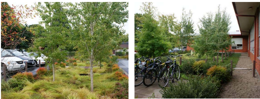
Figur 12 Exempel på utformning av regngårdar vid en grundskola. Avvattnings sker från omgivande parkeringsytor och tak.
