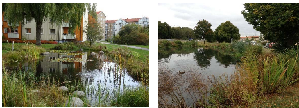
Figur 15 Flera exempel på dagvattendammar med naturlig utformning i bostadsnära bebyggelse.
