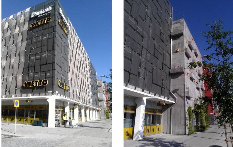
Figur 9 Parkeringshuset i kvarteret Fullriggaren, Västra Hamnen i Malmö.
