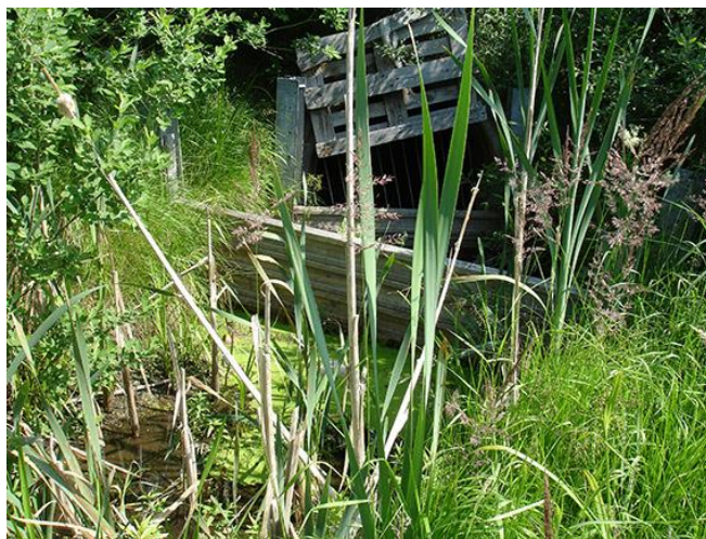
Gammalt dämme vid kulvert vid utfart till Nacka Trä.
