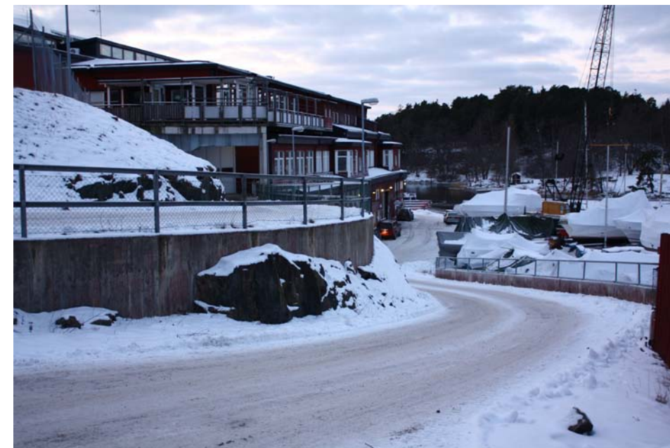
Dubbla ramper med stödmurar
