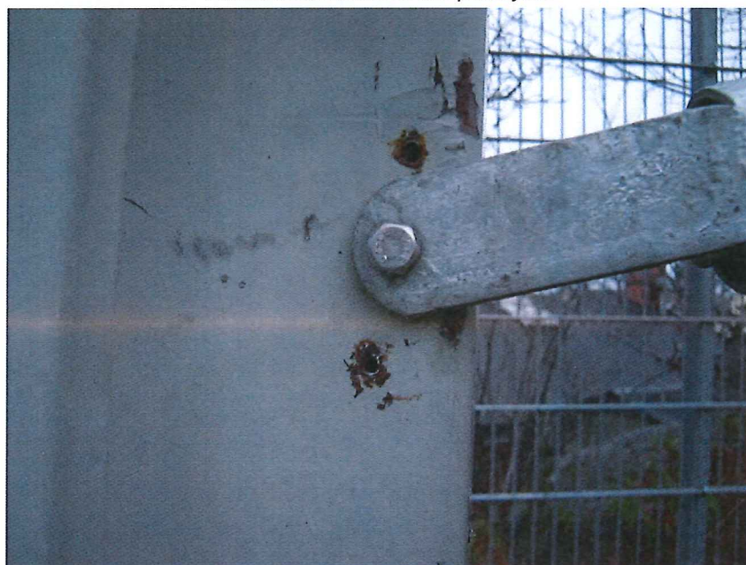
Borrhål som korrosion har påbörjats.
