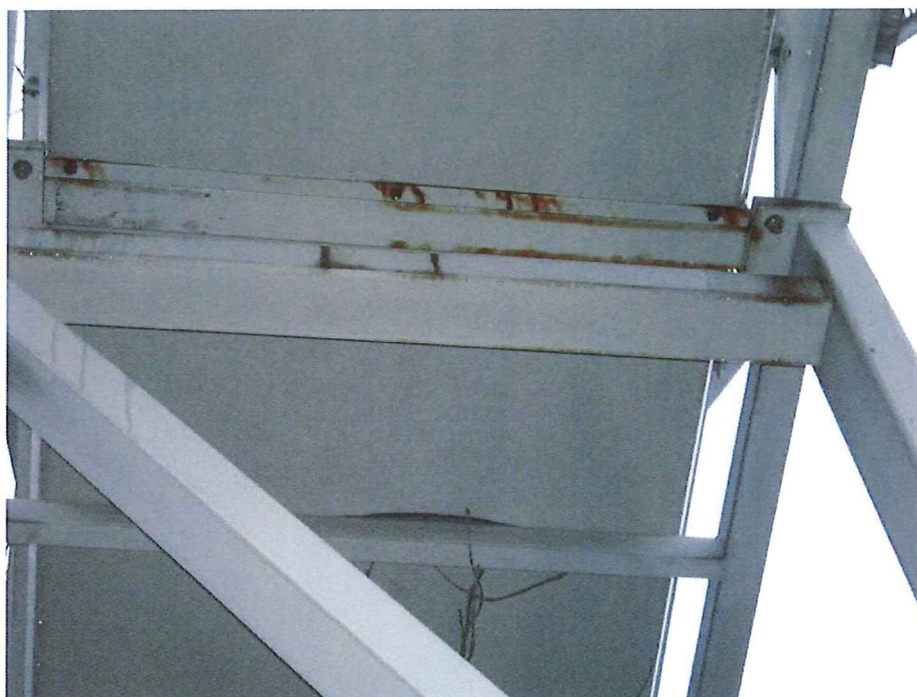
Korrosion på tvärbalk vid mellanstödet.
