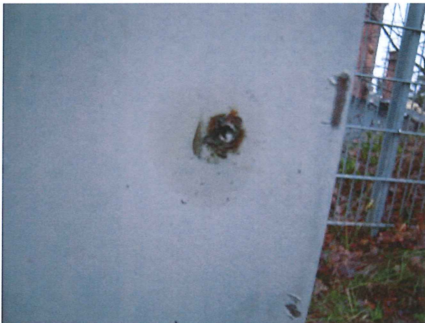
Borrhål som korrosion har påbörjats.
