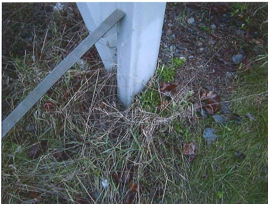
Igenväxt pelarfot och fundament saknas.
