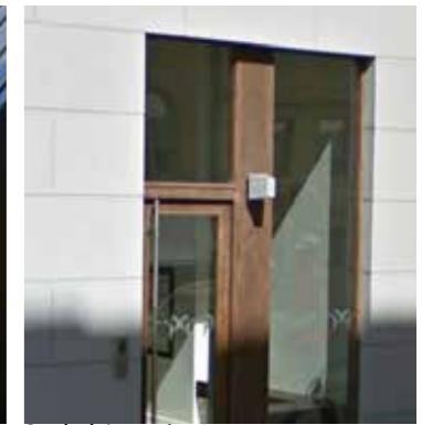
Sockel / entréer i sten.
