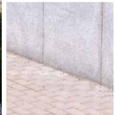
Sockel / entréer i sten.
