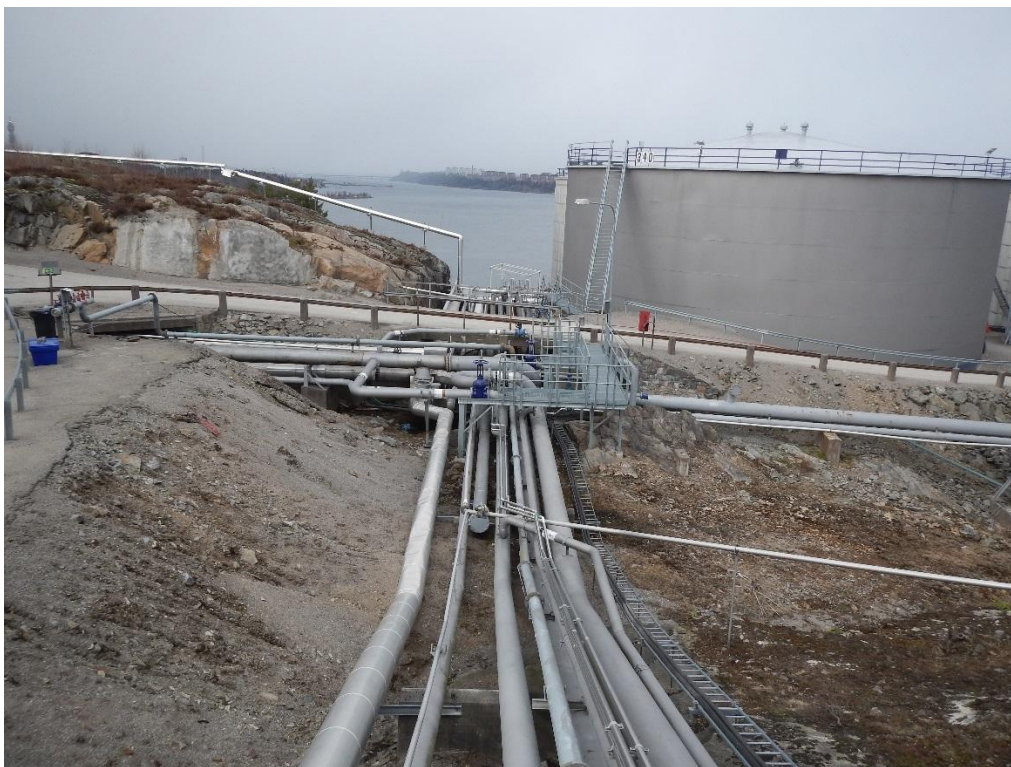
Foto 5. Ledningsstråk där framtida växtfiltreringssystem samt dagvattenkanal föreslås
