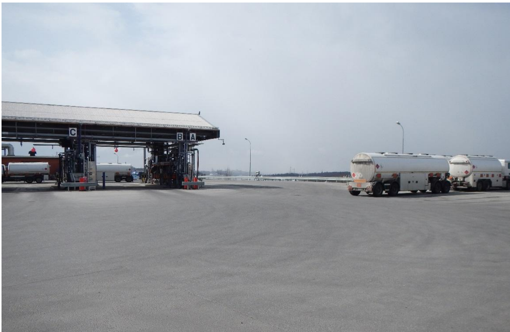
Foto 1. Befintlig lastplats för tankbilar.
