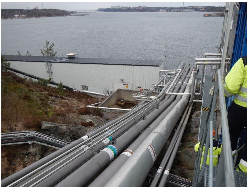
Foto 6. Ledningsstråk där dagvattenkanal är på förslag, befintlig reningsanläggning i byggnad till vänster i bild
