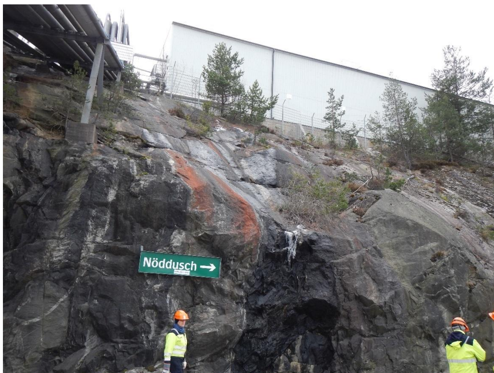
Foto 7. Område där dagvatten föreslås nå recipient i norr, nedströms befintlig byggnad för dagvattenrening.
