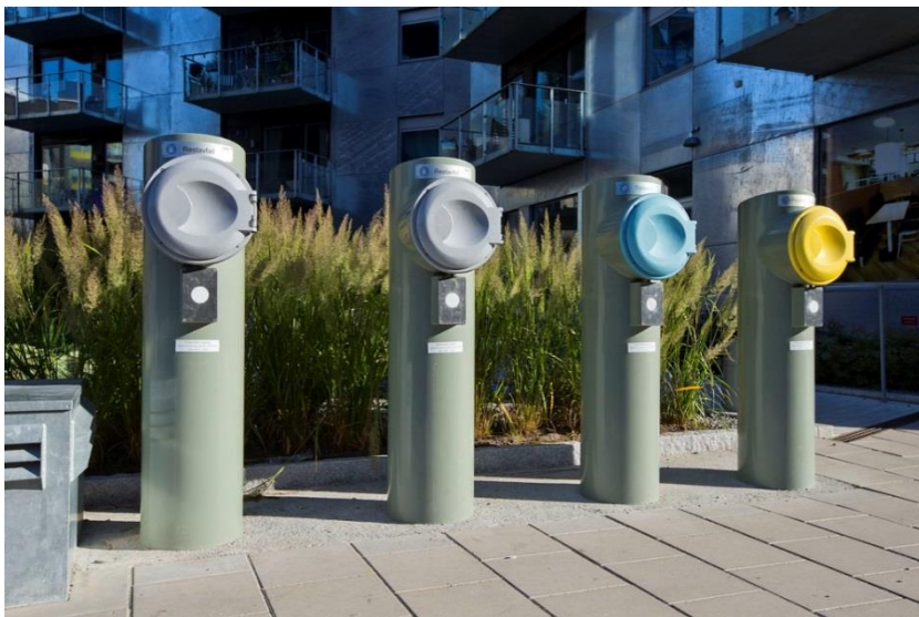
Figur 6, Traditionella inkast i med teknikutrymme undertill, Norra Djurgårdsstaden. Två st för restavfall och ett för plast respektive tidningar. Utrustade med RFID-läsning.
