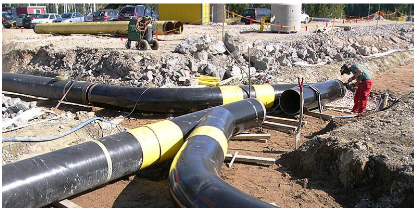
Figur 20, Montage av sopsugsrör.
