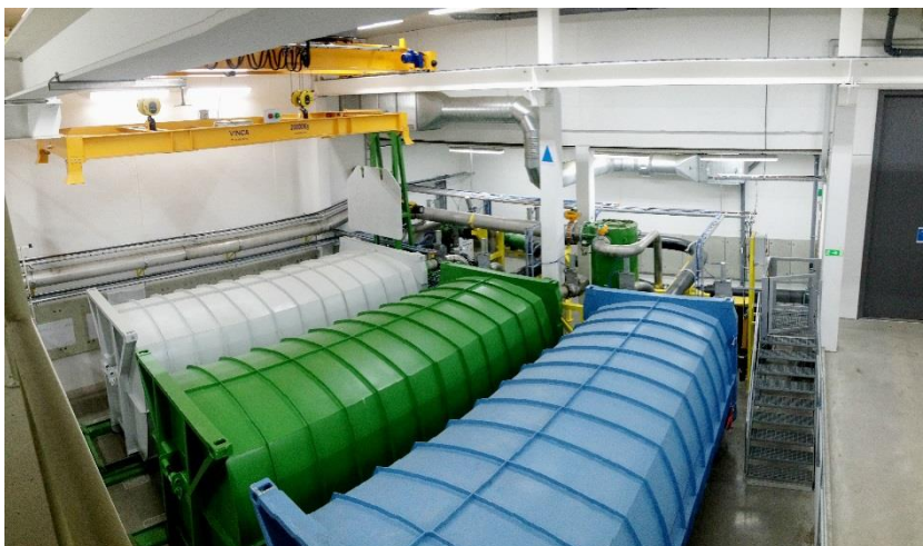
Figur 16, Sopsugsterminal Vällingby Parkstad invändig bild, containrar rangeras med traverskran.
