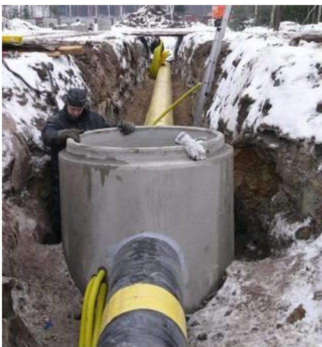
Figur 21, Montage av inspektionsbrunn på sopsugsrör.
