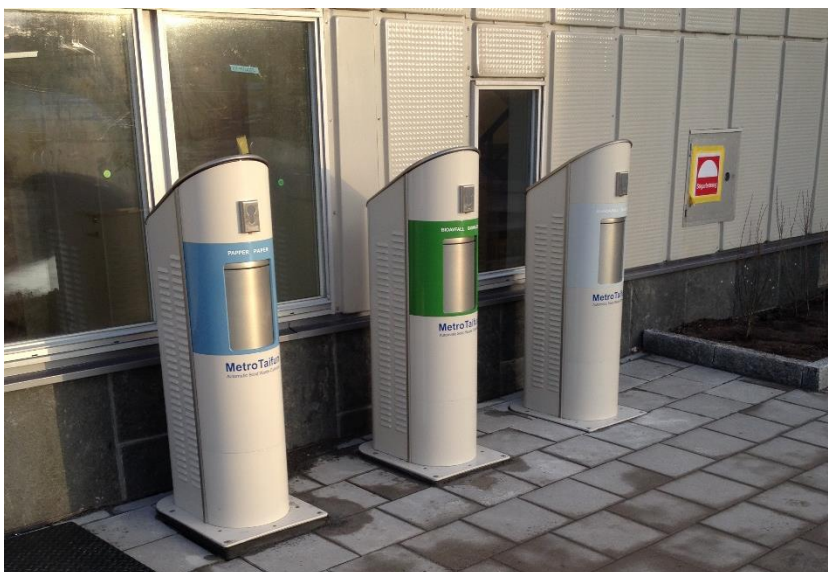
Figur 10, Sopsugsinkast Vällingby Parkstad, MariMatic, tre fraktioner, kräver inget teknikutrymme under mark.
