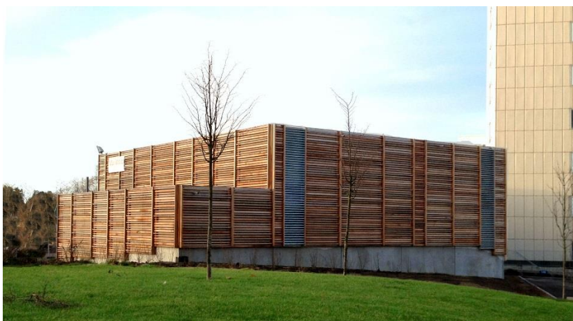
Figur 15, Sopsugsterminal Vällingby Parkstad, MariMatic. Invändig rangering av containrar.
