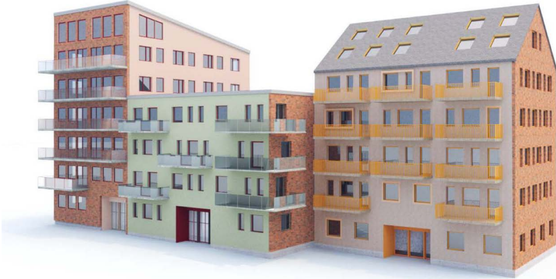
Exempelkvarter – gavlar i tegel, kulörer från paletten, inga balkonger ovan entréer (Bild: Mandaworks)
