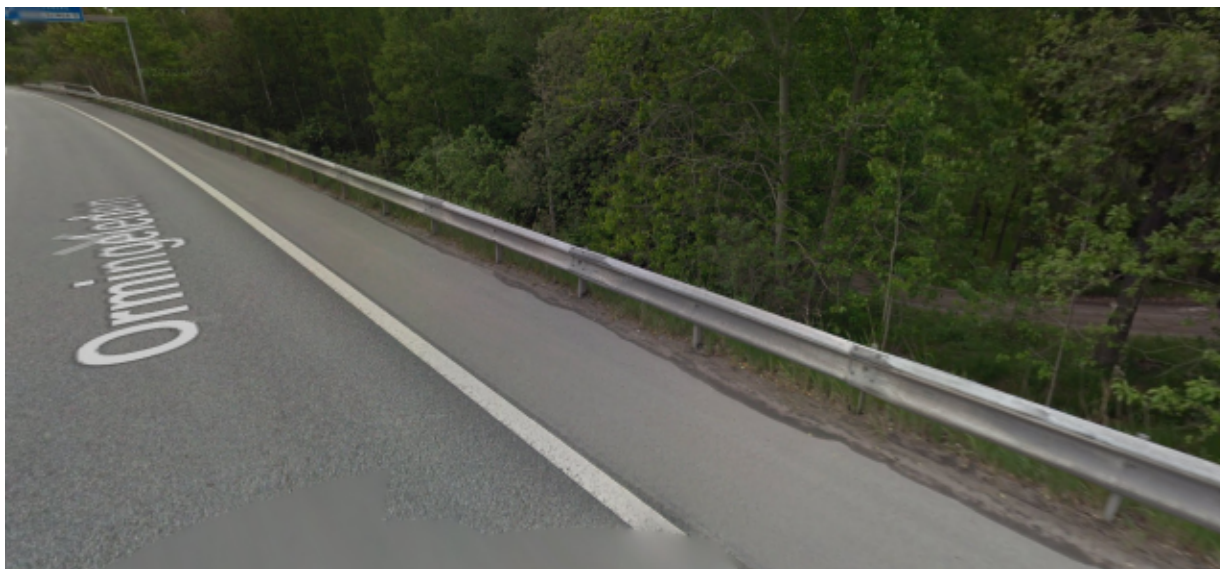
Figur 11. Avkörningsskydd finns mellan Ormingeleden och slänten mot området. I släntens slut kan Fågelstigen skymtas. Bildkälla: (Google, 2014)
