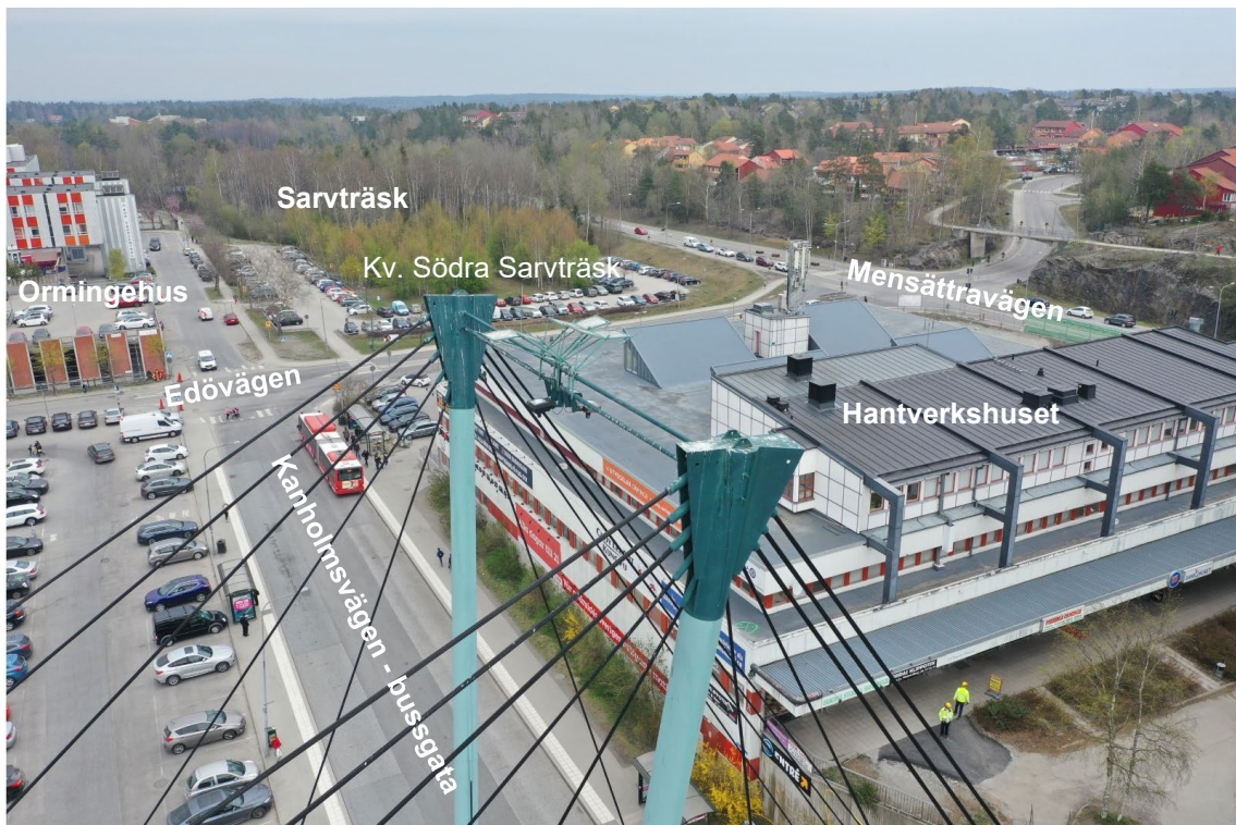
Figur 4 Flygbild över Kanholmsvägen från gångbronsens pyloner mot Sarvträsk. Hantverkshuset till höger, Ormingehus övre vänstra hörnet. Foto: Nacka kommun, Bygg- och anläggningsenheten, våren 2019.
