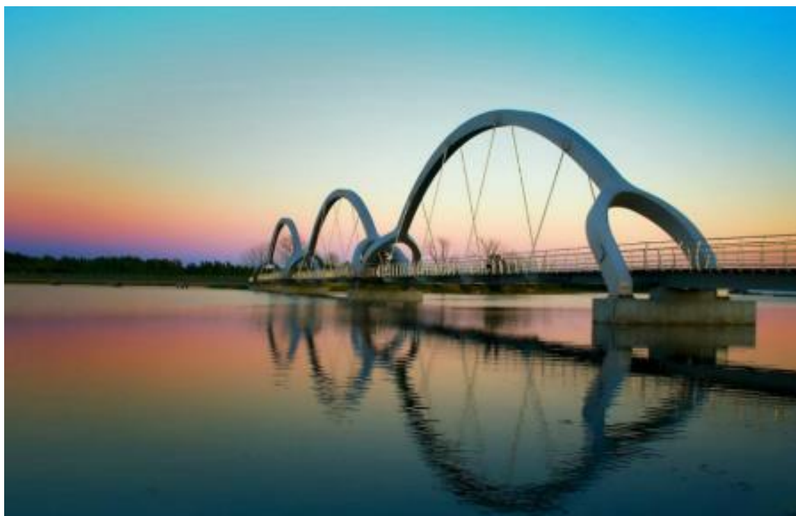
Figur 10: Bågbro i rostfritt stål med generös spannvidd, bild från Stål & Rörmontage AB.
