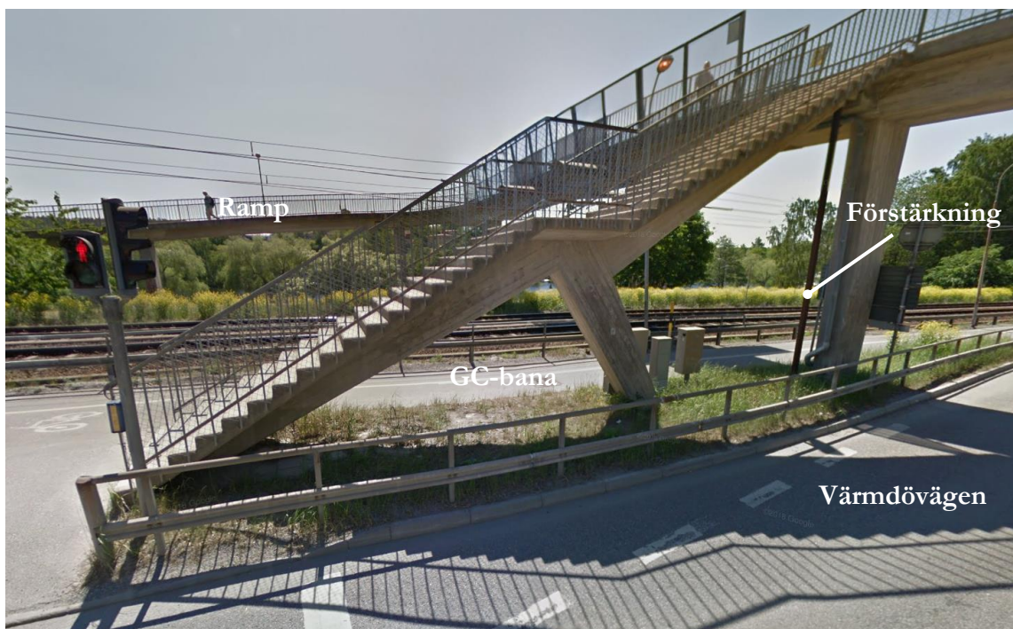
Figur 3: Armerad betongtrappa vid S-105. Vy mot söder.
