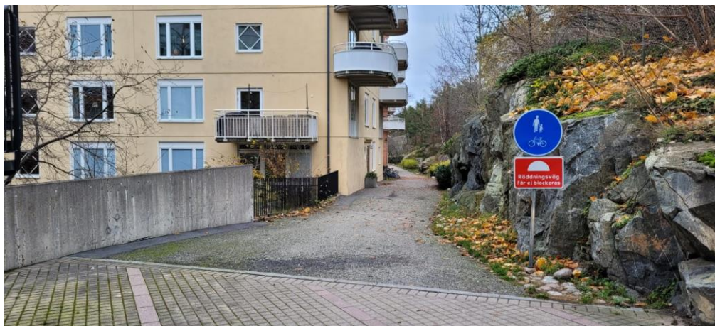
Bild: gång- och cykelbana på brandgatan
