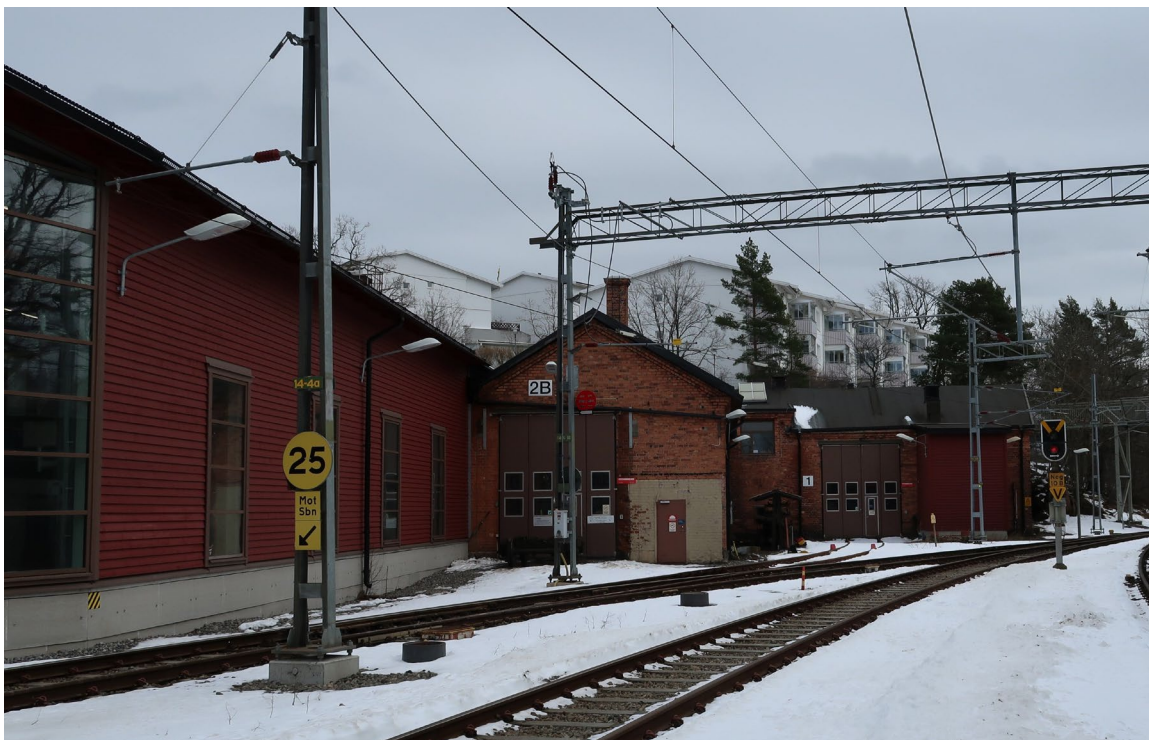
Figur 3: Tegel, liggande träpanel och fönster med vertikala former är viktiga karaktärsdrag hos den befintliga depåbyggnaden. Närmast i bild syns tillbyggnaden från 2017/2018. (Nacka kommun, 2023)
