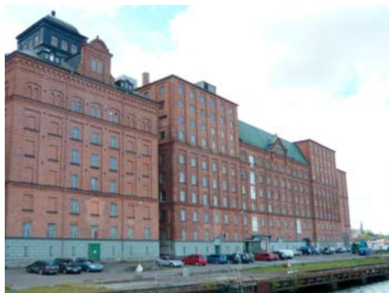
Hus 03-09 från nordost.
