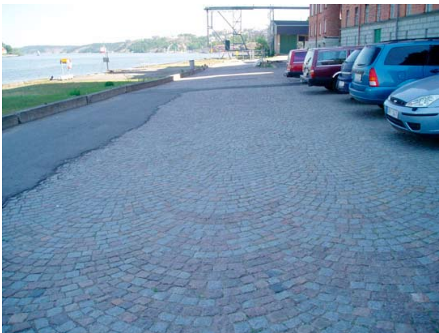
Kvarnplanen består idag till stor del av delvis överasfalterad smågatstensyta.
