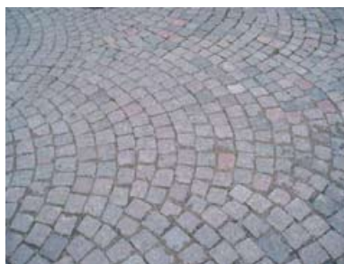
Exempel: Smågatsten i befintligt bågmönster.
