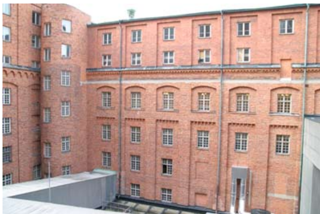
Hus 06 från söder.
