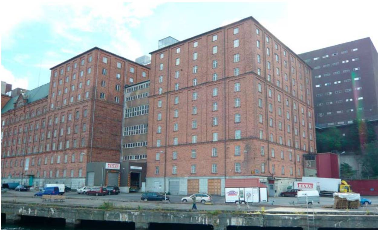
Hus 11 sett från norr.
