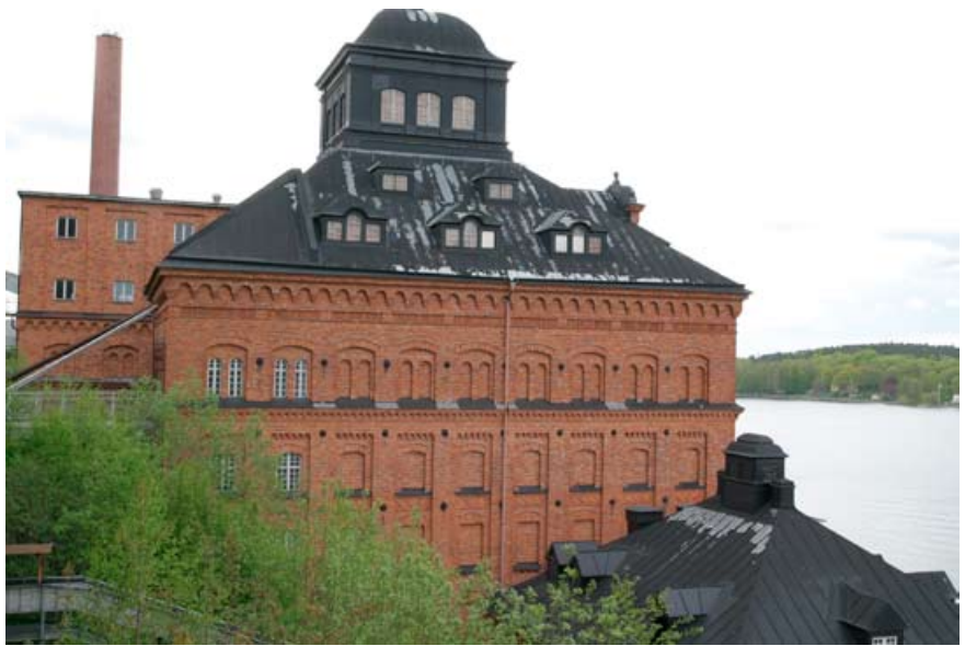
Fasad och tak mot öster.
