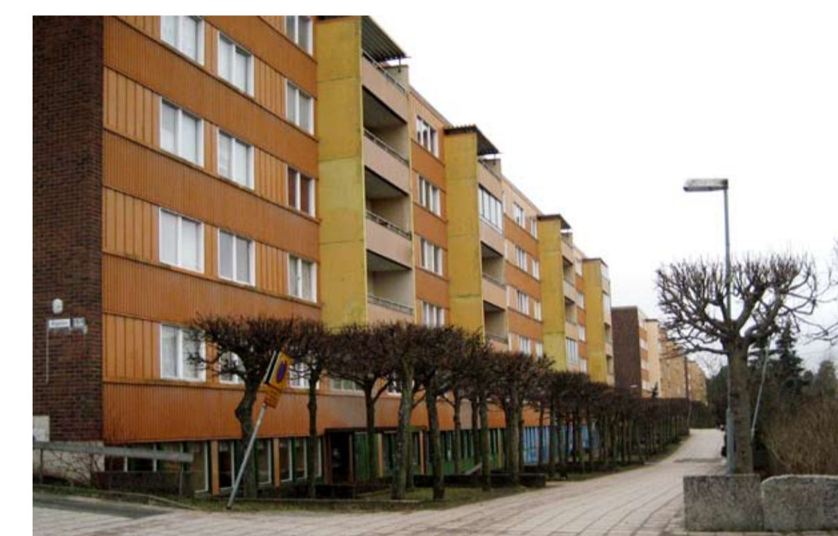
Den långa öst-västliga axeln, Fisksätra allé, är välskött och vacker och dessutom nyligen upprustad, men, saknar intressanta målpunkter i ändarna och bottenvåningarna är ofta outnyttjade.
