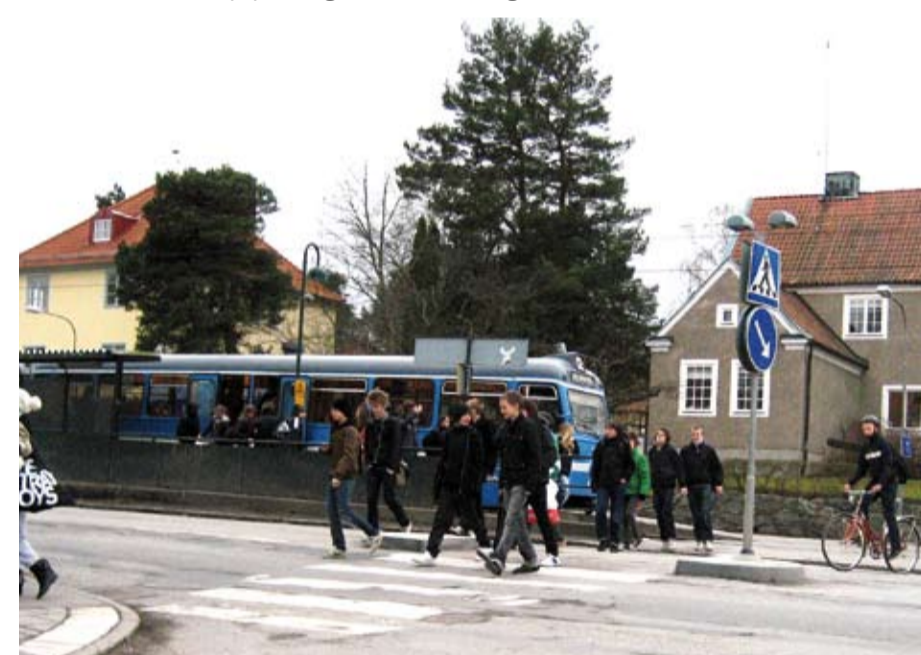
Saltsjöbanan byggs om med nya perronger för ökad bekvämlighet.
