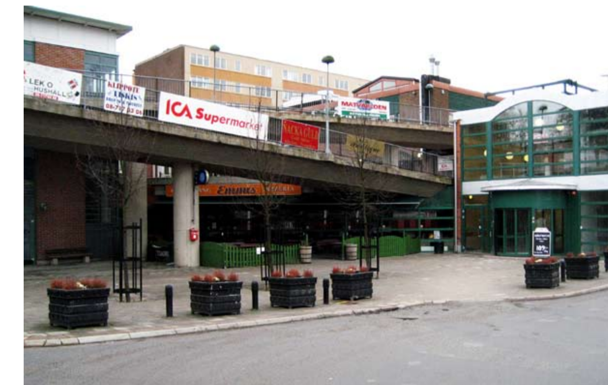
Centrum är slitet. Byggnaden är sluten utåt med några gallerförsedda fönster. Butiker och service ligger på tre plan pga de olika kraven på trafikseparering med entréplanet. Fisksätra är ett relativt stort område vilket gör att det bör kunna finnas underlag för centrum och dess framtida utveckling.
