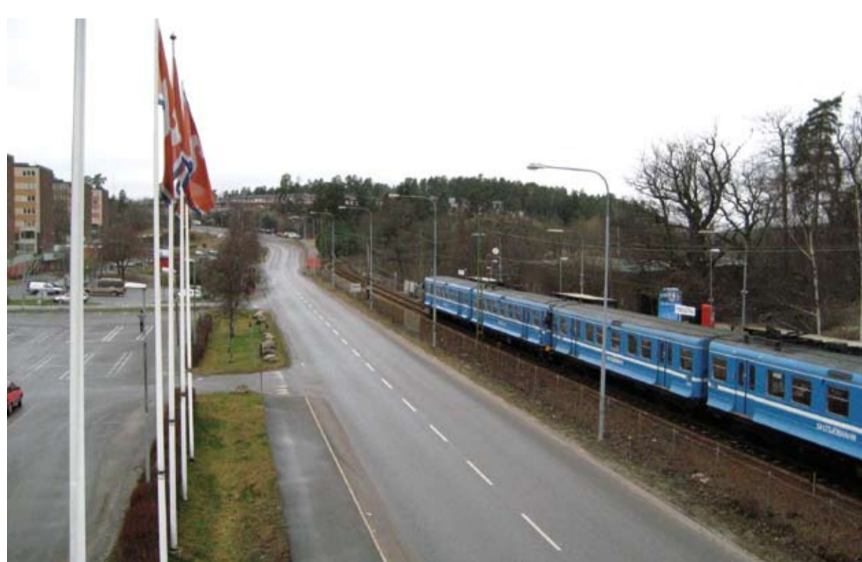
Ringleden runt området är som en landsväg, överdimensionerad med avsaknad av detaljer.
