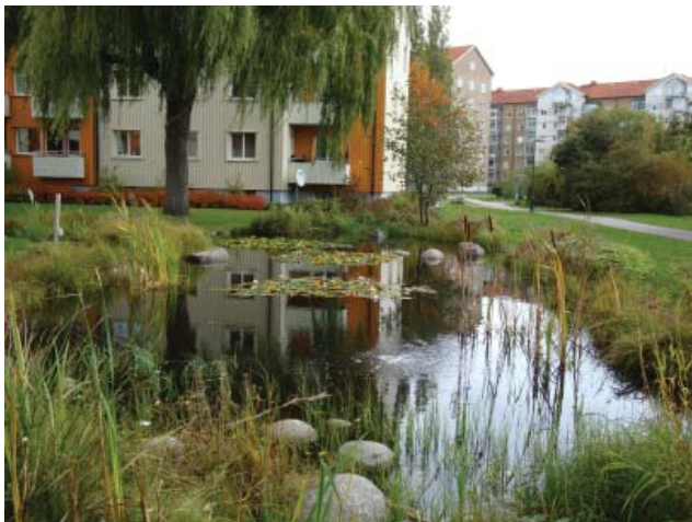
Dagvattenhantering med dagvattendamm, Sweco, dagvattengruppen
