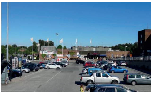
Saltsjöbaden centrum idag, sett från parkeringsplatsen.
