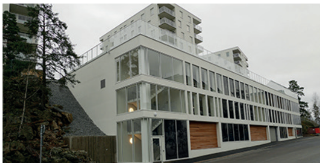
Parkeringsgarage i brant terräng utmed Oxelvägen i Älta. Arkitekt: Sjögren arkitekter AB.
