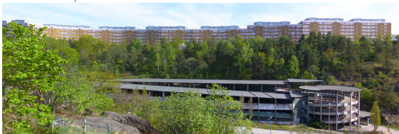
Henriksdalsberget, parkeringsgarage längs med Kvarnholmsvägen i förgrunden, vy från norr.
