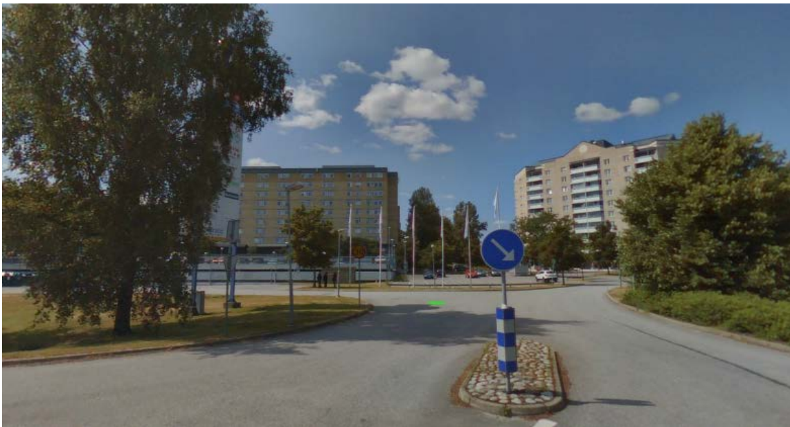
Figur 6. Befintlig entré till Älta centrum från Ältavägen, öster om området.
