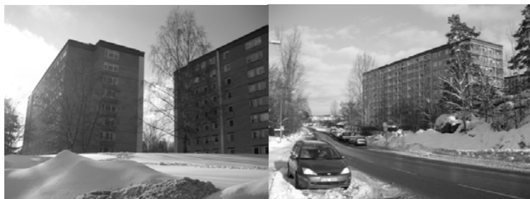
lamellhus längs Oxelvägen
