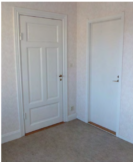
Övervåningen i Norra villan. Spegeldörrar med profilerade foder bör bevaras i största möjliga uträkning.
