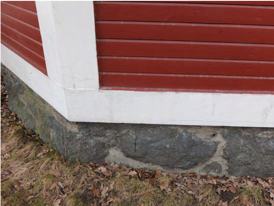
En fotbräda – utan plåt på delar av fasaden - markerar bottenbjälklaget och fasadens möte med den grova sockeln. En plåtavtäckning skulle ett klumpigare intryck.
