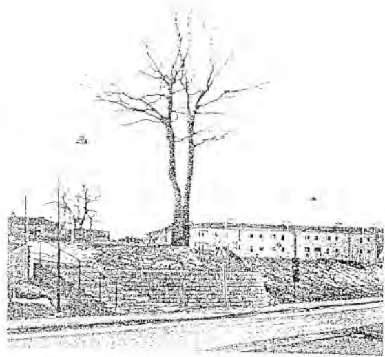
Eken med sin nya stödmur
