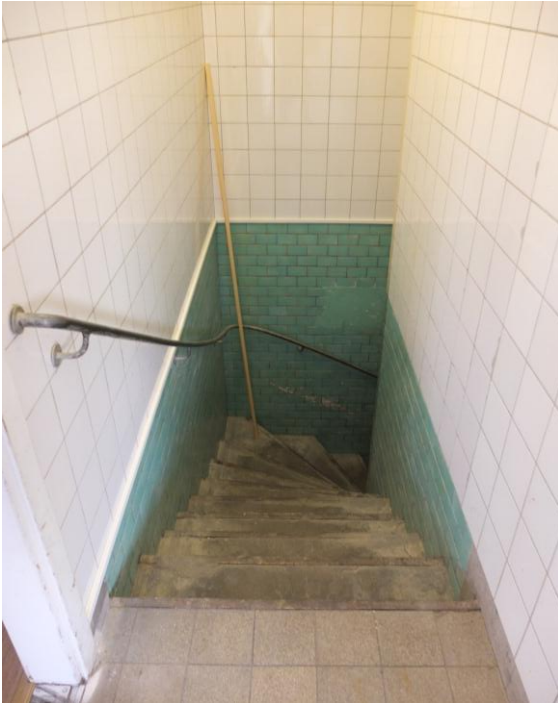
Trappan ner till källaren, med grönt kakel, ska bevaras.
