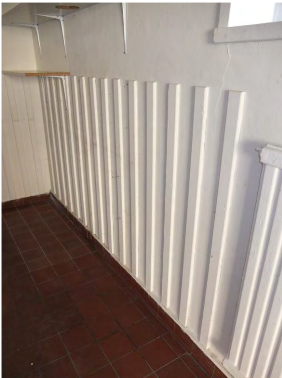
Träribbor som skydd för väggen.
