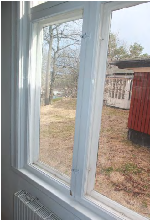
Södra villan har bevarade okopplade fönster.
