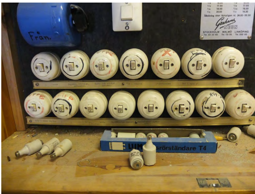
Elskåp från butiksepoken. Under varje strömbrytare kan man fortfarande utläsa vilken del av butiken som lystes upp.
