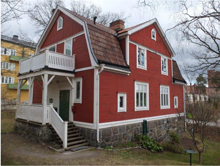
Norra villans västra och södra fasader.
