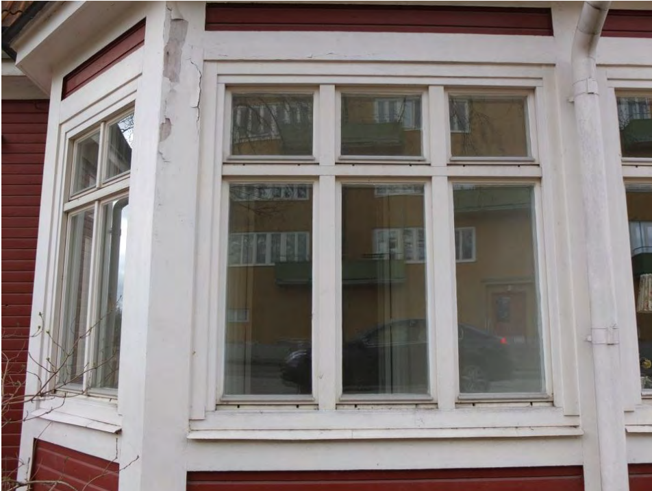
Villans fönster är bytta mot treglasfönster i instickskarmar.
