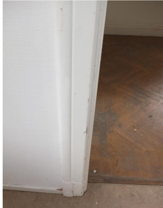
En typ av dörr- och fönsterfoder som förekommer i Södra villan.
