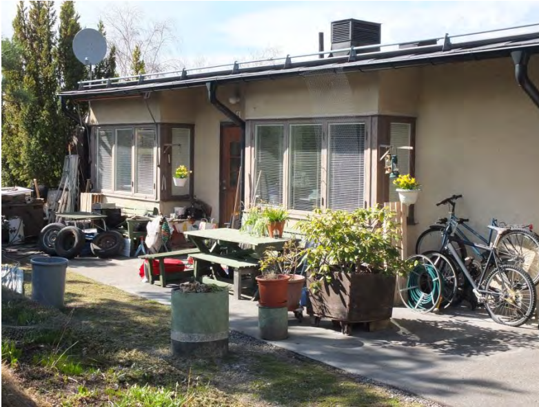
Lägenheterna med burspråk. Fasad mot söder.
