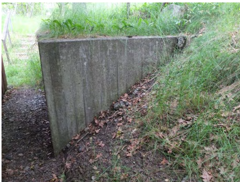
En formgjuten betongmur i området, som kan tjäna som förebild vid utformning av nya stödmurar i anslutning till konsumhuset.
