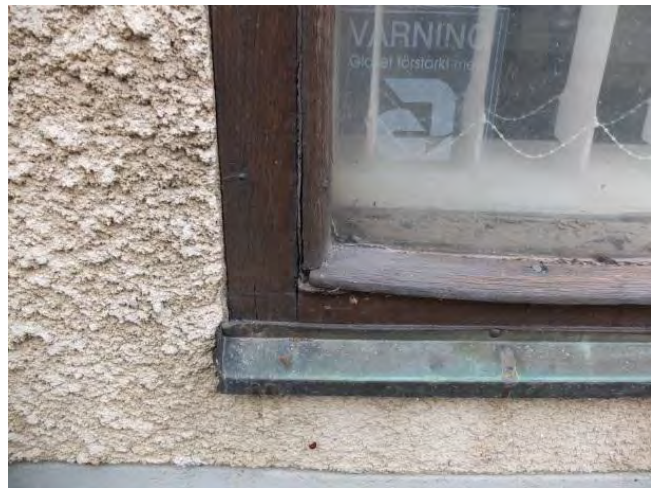
Detalj av skyltfönster.
