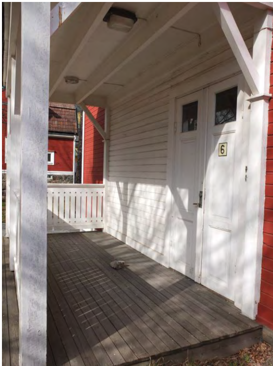
Västra verandan med en äldre entrédörr.
