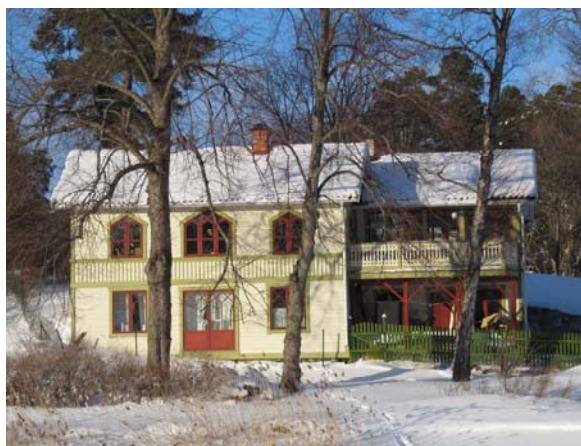
Björkuddsvägen 12, fasad mot Maren. Foto 2010
