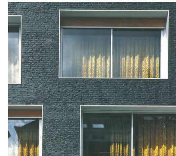
Bra exempel på hål i mur med detaljerad fönsternisch Studentboende (Claus en Kaan Architecten)
