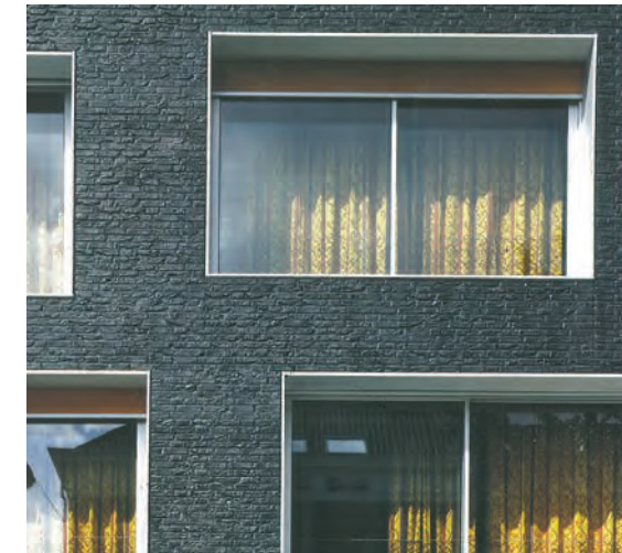
Bra exempel på hål i mur med detaljerad fönsternisch Studentboende (Claus en Kaan Architecten)
