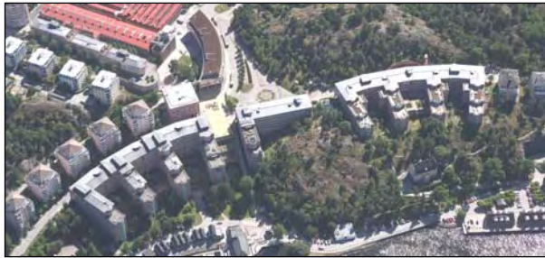
Flygfoto från norr, planområdet omfattar den vänstra av de tre storskaliga byggnaderna i branten.
