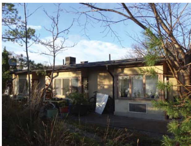
Butikshusets baksida med indragna uteplatser och burspråksliknande fönsterpartier för lägenheterna. Utformningen påminner om radhusens söderfasader med indragna uteplatser. Delar av denna fasad ska kopplas ihop med en ny byggnadsvolym inrymmande förskola. Det är då viktigt att återstående delar behåller sin karaktär.
