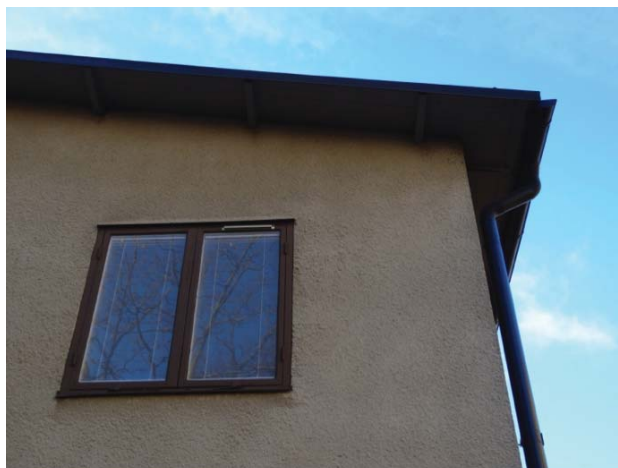
Detalj av fasad med utskjutande taksprång. Synliga taksparrar och tunna plåtavtäckningarna ger taket ett lätt uttryck. Nedanför ett tvåluftsfönster som ligger i liv med fasadytan. Från början var fönstren vita och fasaderna slätputsade i en ljusare kulör.
