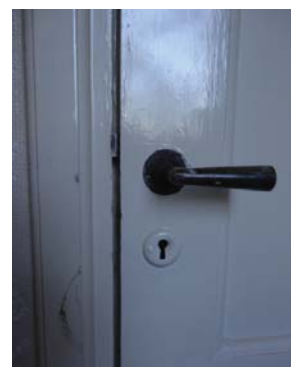
Dörrfoder, trycke och nyckelskylt av 1930-talstyp. Det nätta fodret har en liten profilering utmed ytterkanterna. I snickeridetaljerna har funktionalismen ännu inte blommat ut, vilket kan berätta om att huset befinner sig i ett arkitektoniskt brytningskede.
