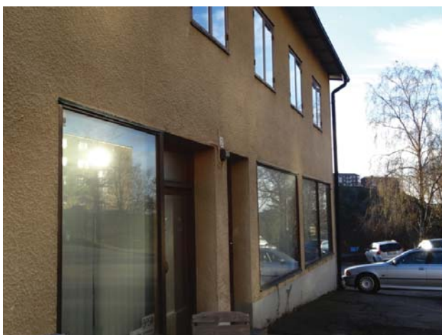
Butiksfönster med bågar av teak. Entrédörrarna är till skillnad från fönstren indragna från fasadliv. Sockeln är putsgrå.
