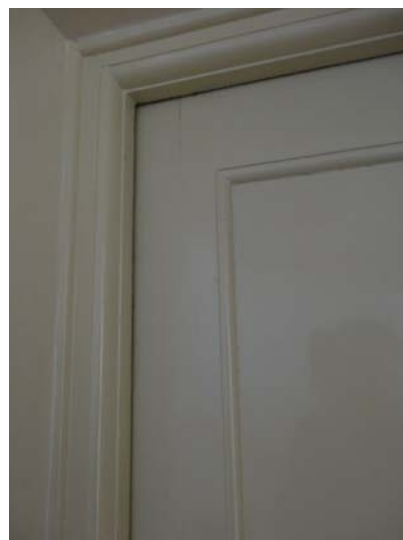
Mjukt formade profiler på dörrkarm och dörrspegel.
