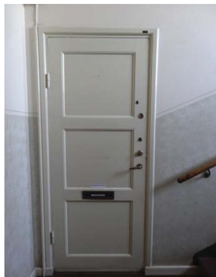
I det äldre lamellhuset hittas denna typ av spegeldörr med tre lika stora speglar som förekom omkring 1930. Dörrtypen finns även i radhusen och bör så långt det är möjligt bevaras. Funktionalismens helsluta dörrblad hade ännu inte kommit i bruk. Dörrfodren har slanka dimensioner. Om lägenhetsdörrar mot trapphus måste bytas ut bör man utgå från befintlig utformning.
