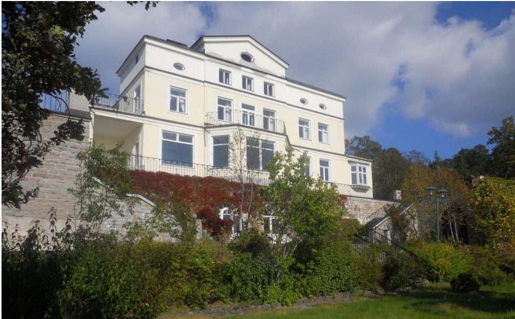
Huvudbyggnadens sydsida som vetter mot Baggensfjärden. (Byggnad nummer 5)
