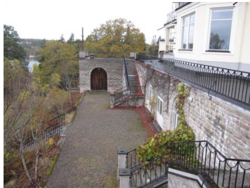
Del av terrasanläggningen. (Byggnad nummer 5)
